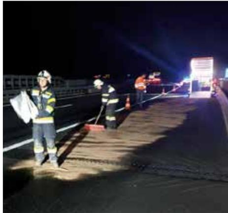
Als erstes Fahrzeug traf das **MTF Steinberg mit dem Ölschadensanhänger** an der Schadensstelle ein. Sofort wurde die **erste Fahrspur abgesichert** und der Verkehr auf die Überholspur geleitet. Danach wurde mit den **Ölbindarbeiten** begonnen, und nach etwas **mehr als einer Stunde** konnte die Schadensstelle für die endgültigen Aufräumarbeiten an Mitarbeiter der **AS-FINAG** übergeben werden.
