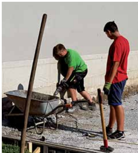
Foto: Ferialarbeiter im Einsatz
