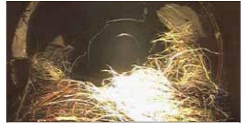
Wurzeln ins Kanalrohr gewachsen
