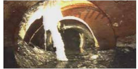
Permanenter Grundwassereintritt durch Scherbenbruch am Kanalrohr
